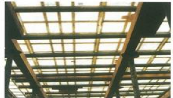
スラブの施工
