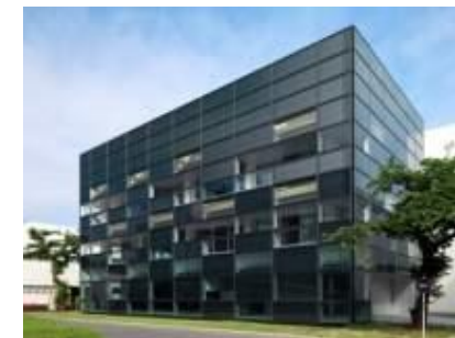
OPV外壁ゼロエネルギービル(ZEB)
